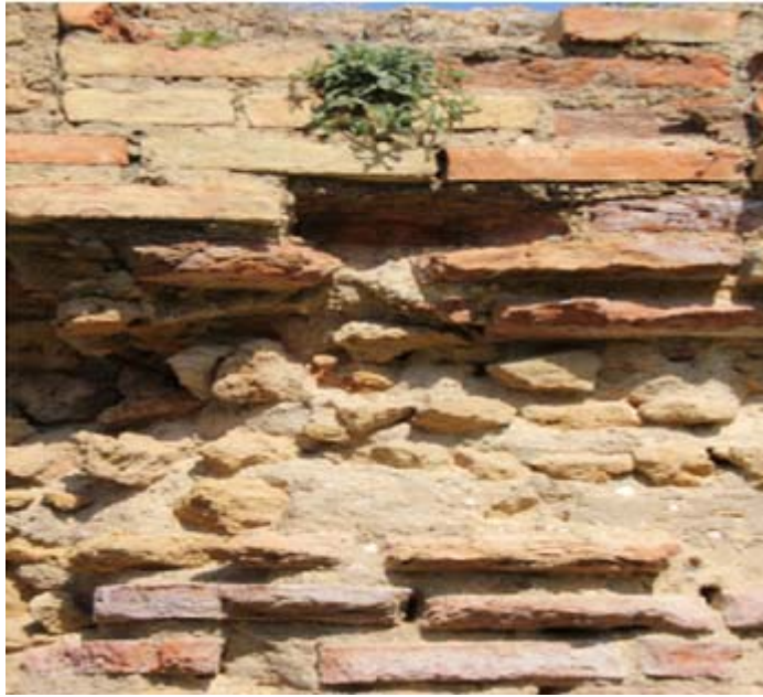
( الصورة رقم 70 ) ملاط خشن ممزوج بالحصى.
