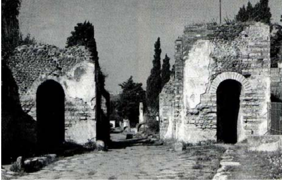
( الصورة 17) باب بمدينة بومبي بتقنية المختلطة، عن ADAM, LA CONSTRUCTION ROMAINE, P 153.
