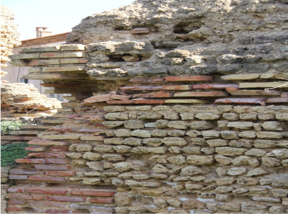
( الصورة رقم 43 ) : جدار بتقنية المزدوجة المتناوبة.
