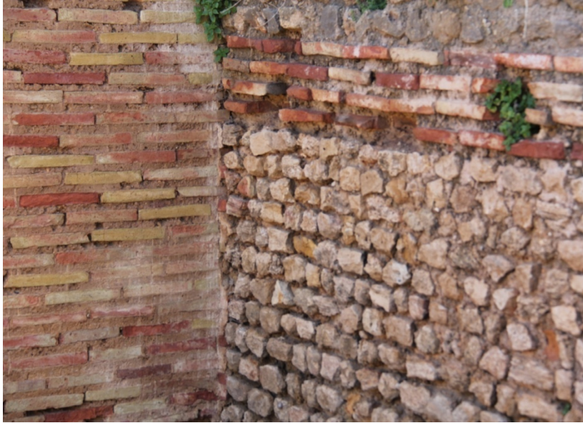
(الصورة رقم 41 ) : جدار بتقنية الصفوف المنتظمة في الحمامات الغربية.
