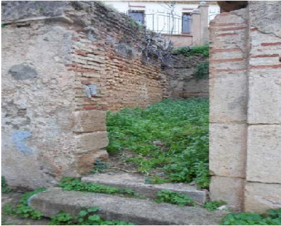
(الصورة رقم 56 ) تقنية تصفيف الاجر في احدى الغرف.
