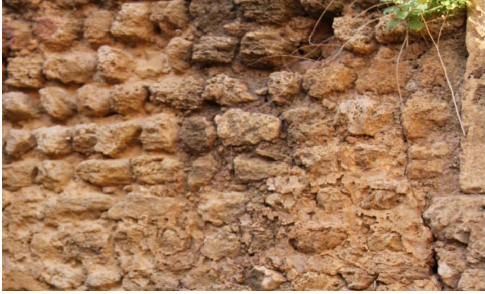
(الصورة رقم 67) جدار بتقنية ركم الدبش على الطين.
