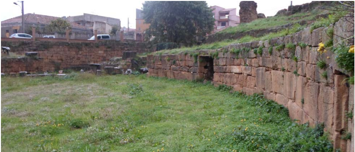
( الصورة رقم 80 ) استعمال الحجارة المصقولة دون ملاط.
