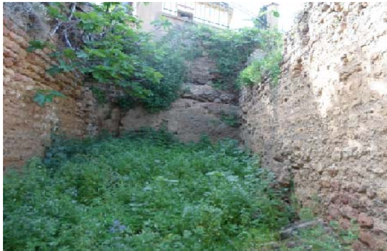
( الصورة رقم 55 ) الجدران الداخلية لإحدى الحجرات.
