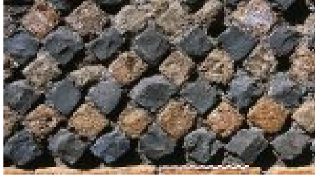
(الصورة رقم 15) جدار بتقنية المعينات (RETICULATUM)
