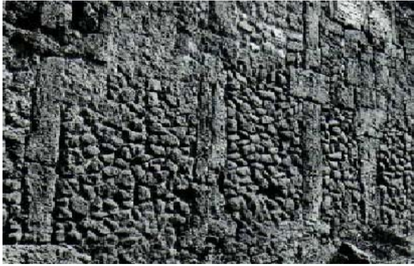
(الصورة رقم 18) جدار بالتقنية الافريقية من مدينة بومبي الايطالية
