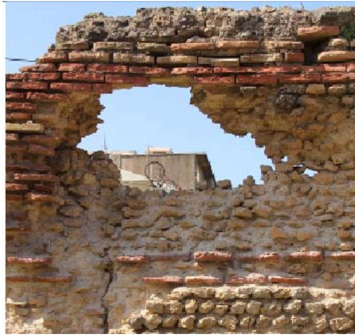
(الصورة رقم 71 ) جدار بتقنية المختلطة
