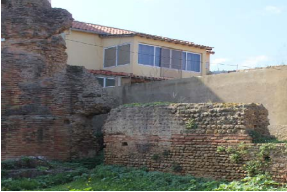
(الصورة رقم 45 ): جدار بتقنية المختلطة في الحمامات الغربية.
